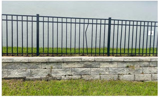
10. RETAINING WALL BEHIND POOL IN TRACT F THERE IS WASHING OUT ON THE LEFT SIDE (FACING PONDS) OF THE WALL.
